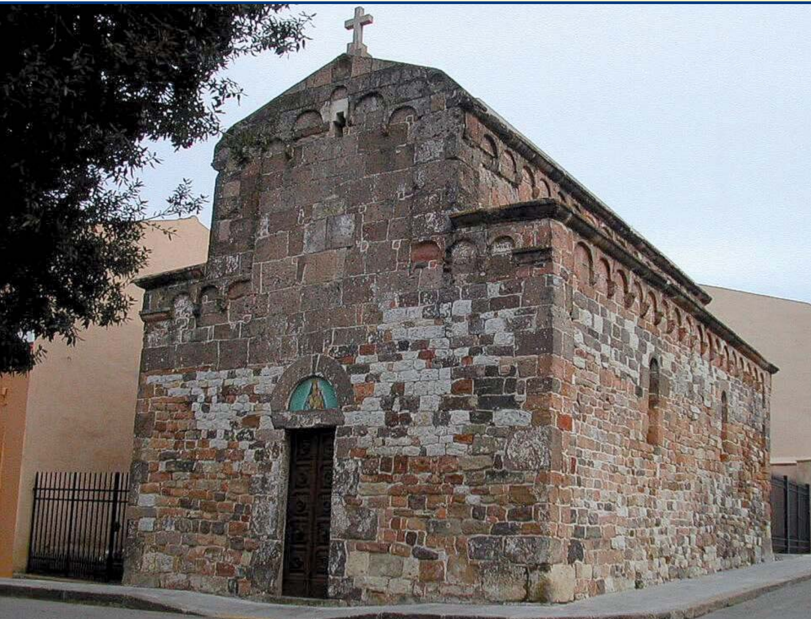
Olmedo (SS). Chiesa di N.S. di Talia XII Secolo (Foto Geom. Marcello Diez).
